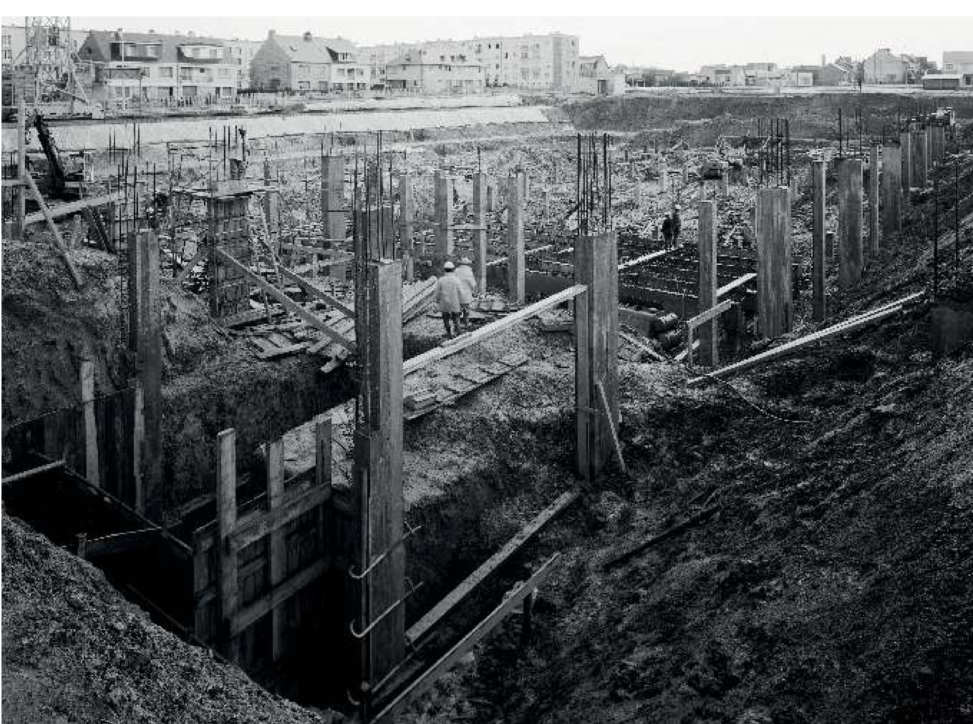
← Pose des fondations de la piscine Bréquigny en 1969
